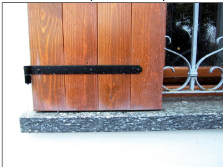
Foto 3: Macchie biancastre puntiformi causate dalla deposizione di pioggia su scuri esterni nuovi.
