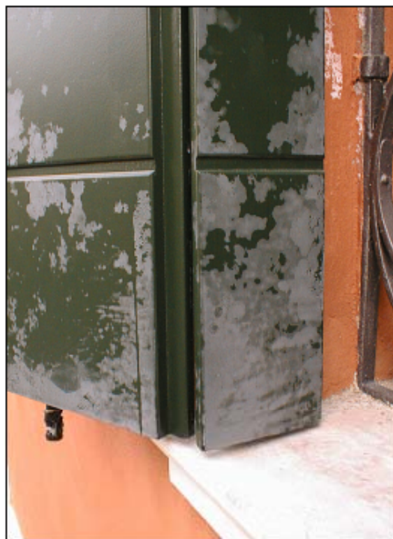
Foto 5: Esempio di scuro di Okumè multistrato con incollaggio fenolico che presenta il fenomeno della fuoriuscita di chiazze biancastre farinose
